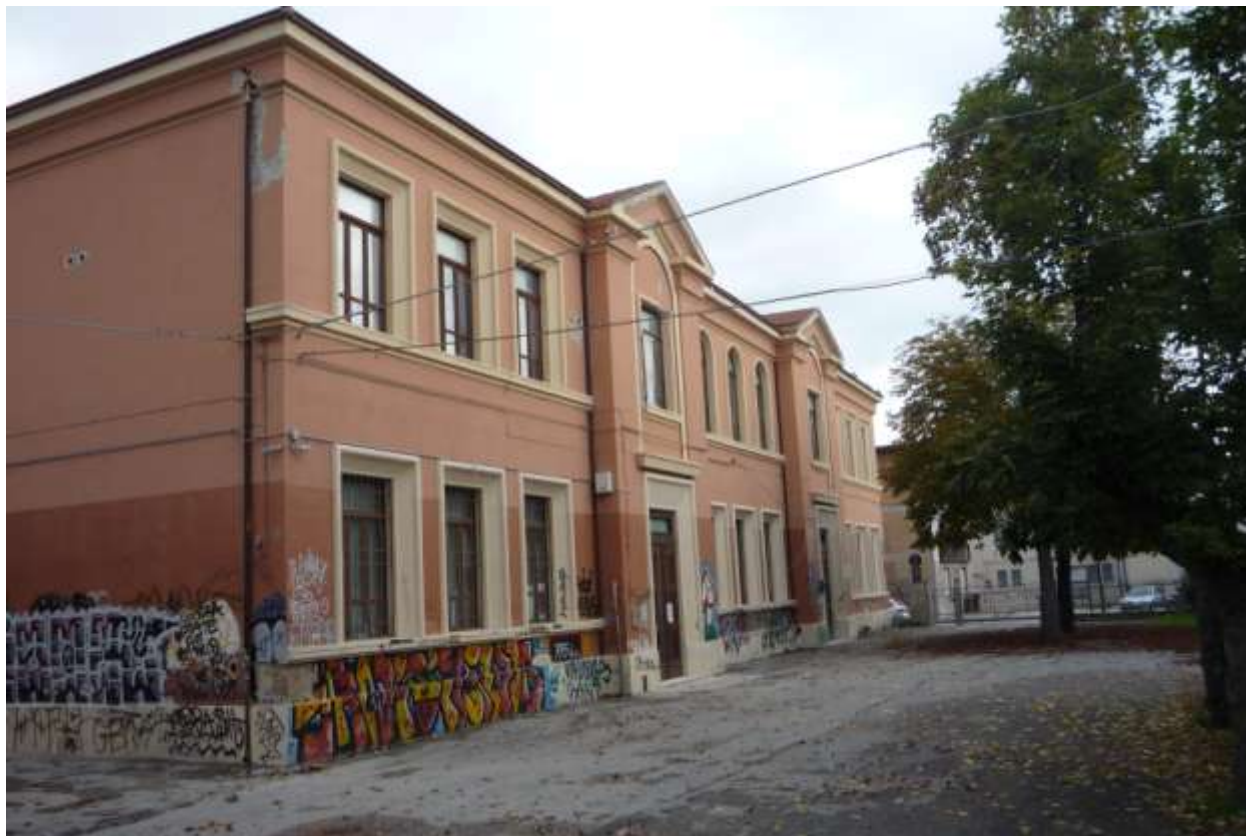
Prospetto principale – Sud-Ovest
