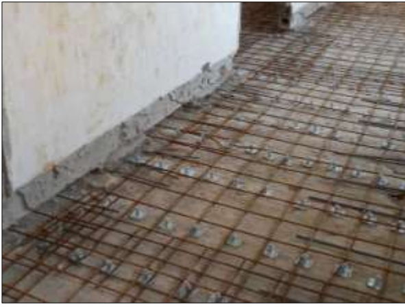
- Rinforzo di solai con soletta armata alleggerita
