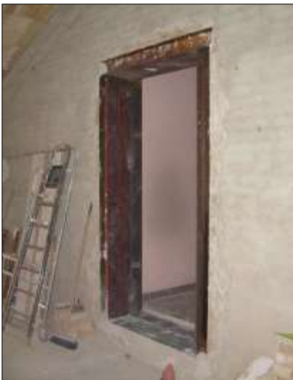
- Cerchiatura delle aperture
