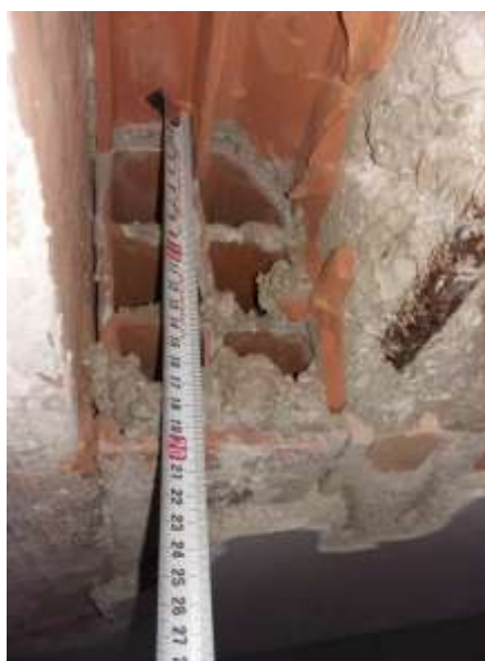
solaio piano terra
