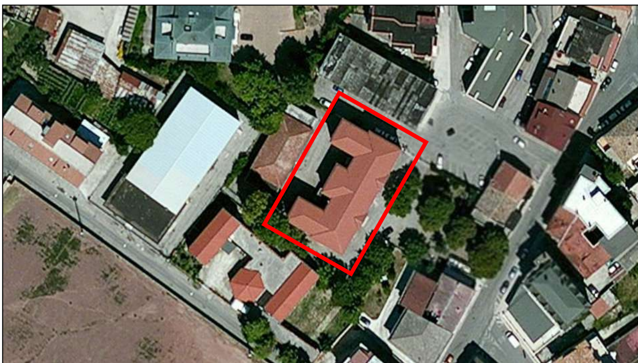
Foto aerea dell'edificio oggetto di analisi
