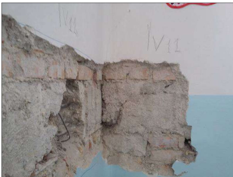
Vista di una Parete non ammassata e del cordolo di piano in c.a.
