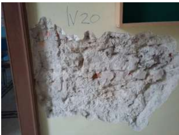
Muratura in pietrame piano terra
