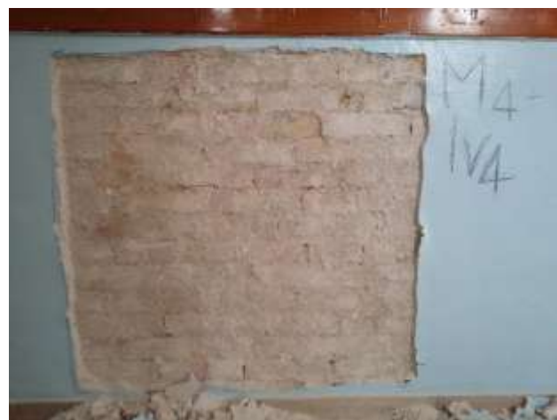
Muratura in mattoni pieni piano terra
