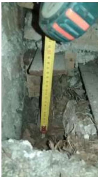
solaio piano primo
